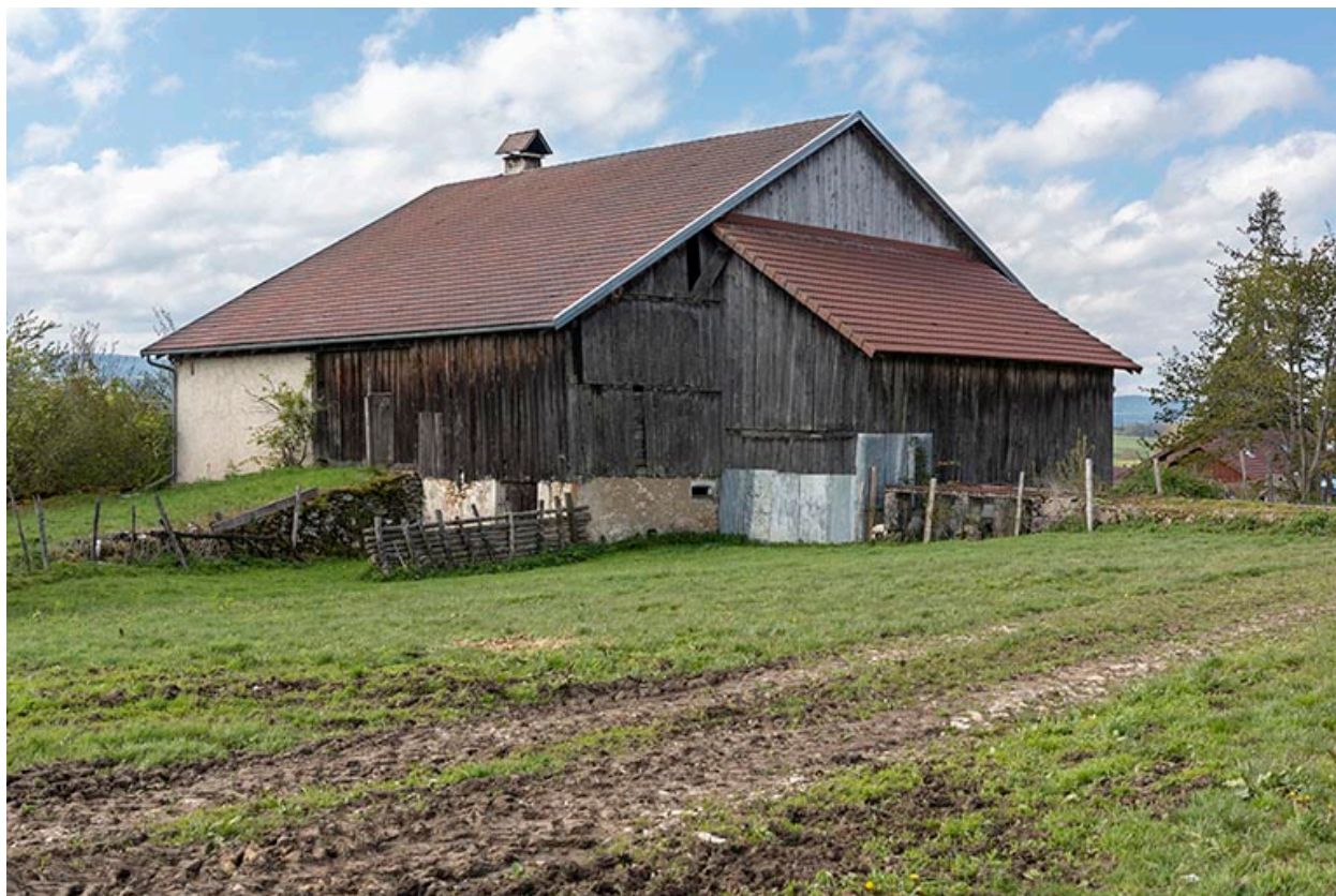
Façades postérieure et latérale droite.
