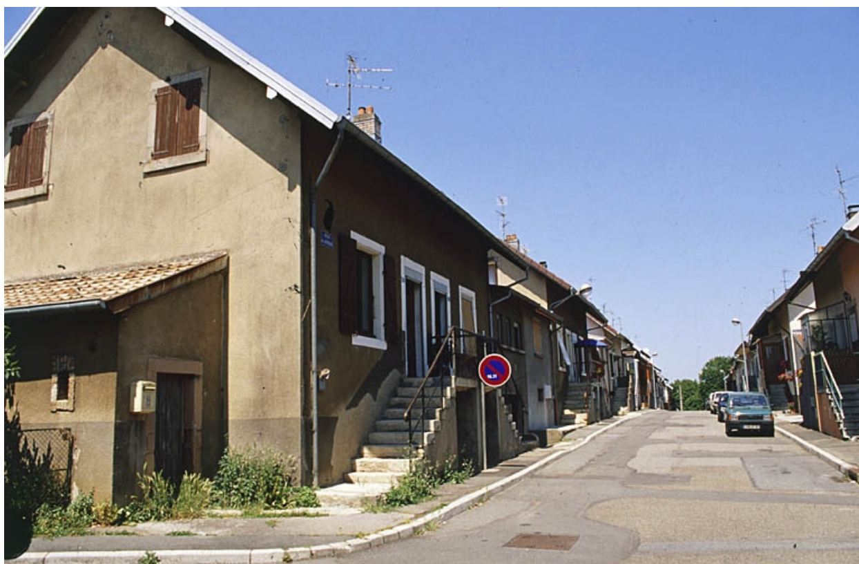
Logements ouvriers rue de la République.
