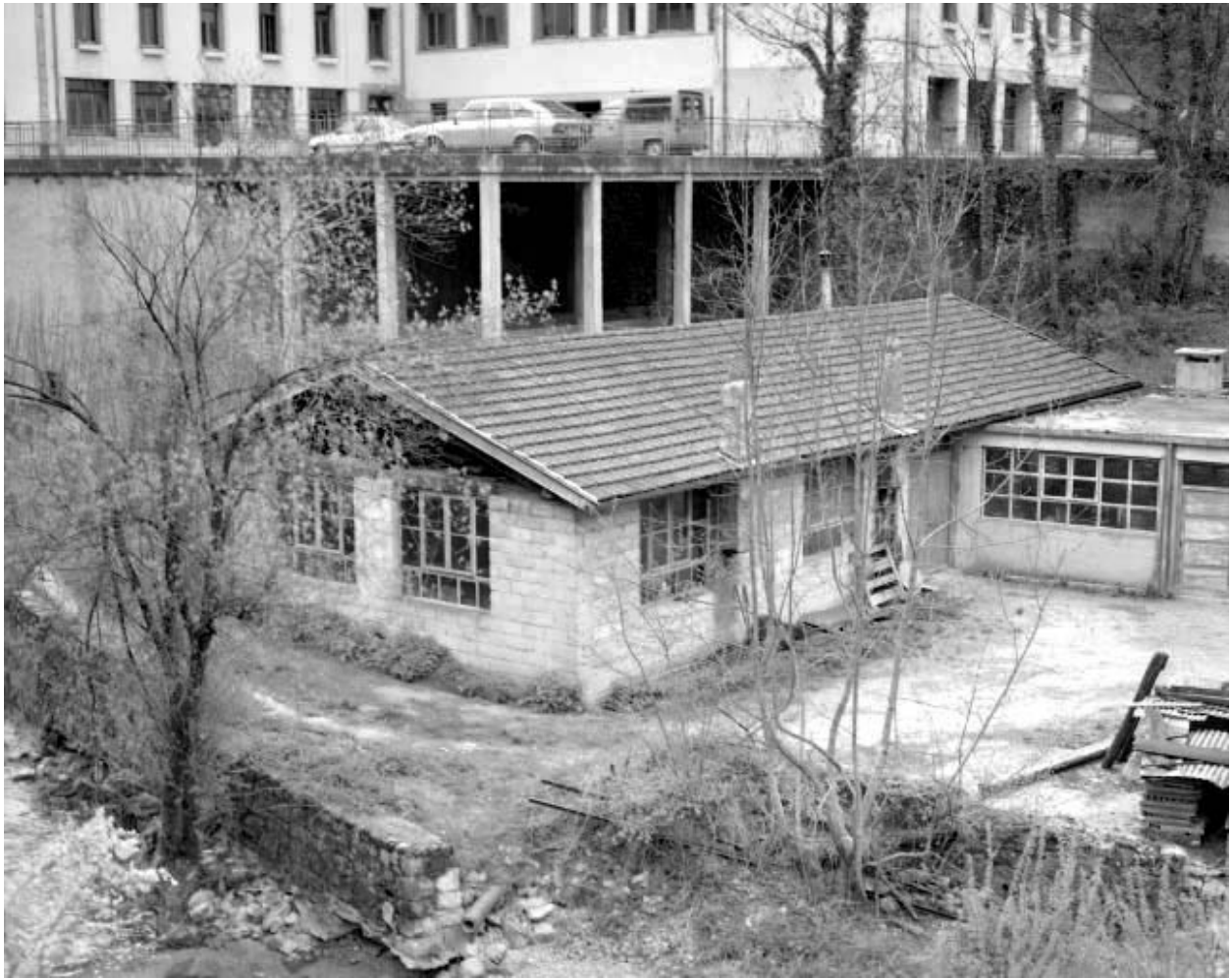
Atelier de fabrication et chaufferie de 1941.
