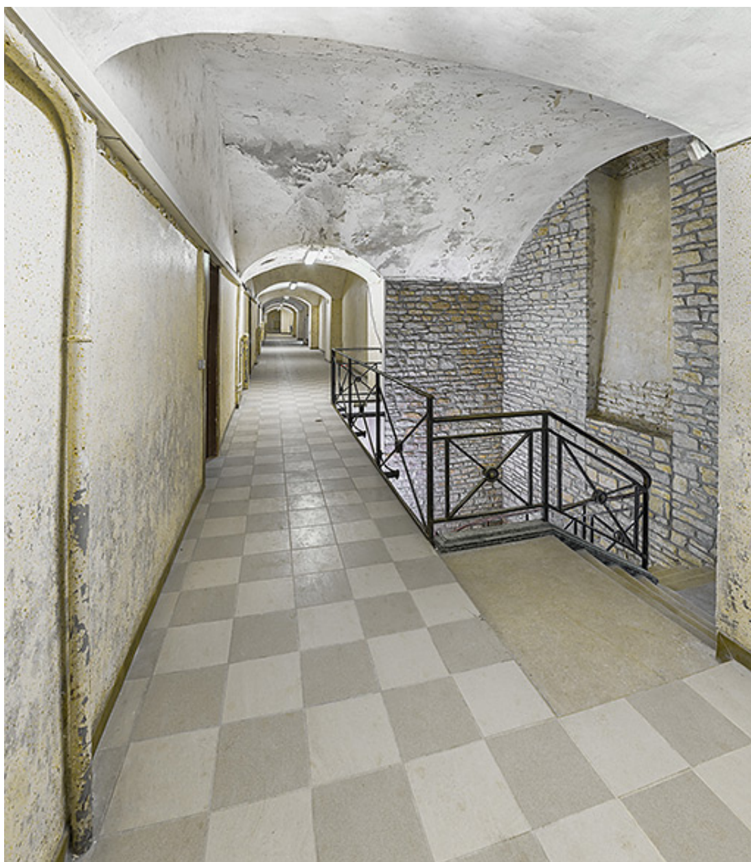
Le fort d'Hauteville : étage du casernement.
