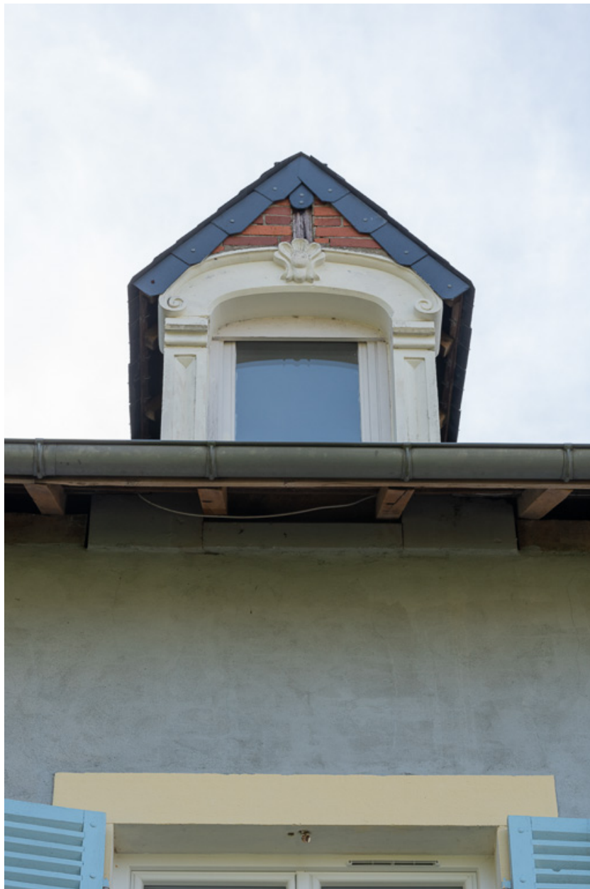
Lucarne de la façade nord-ouest.
