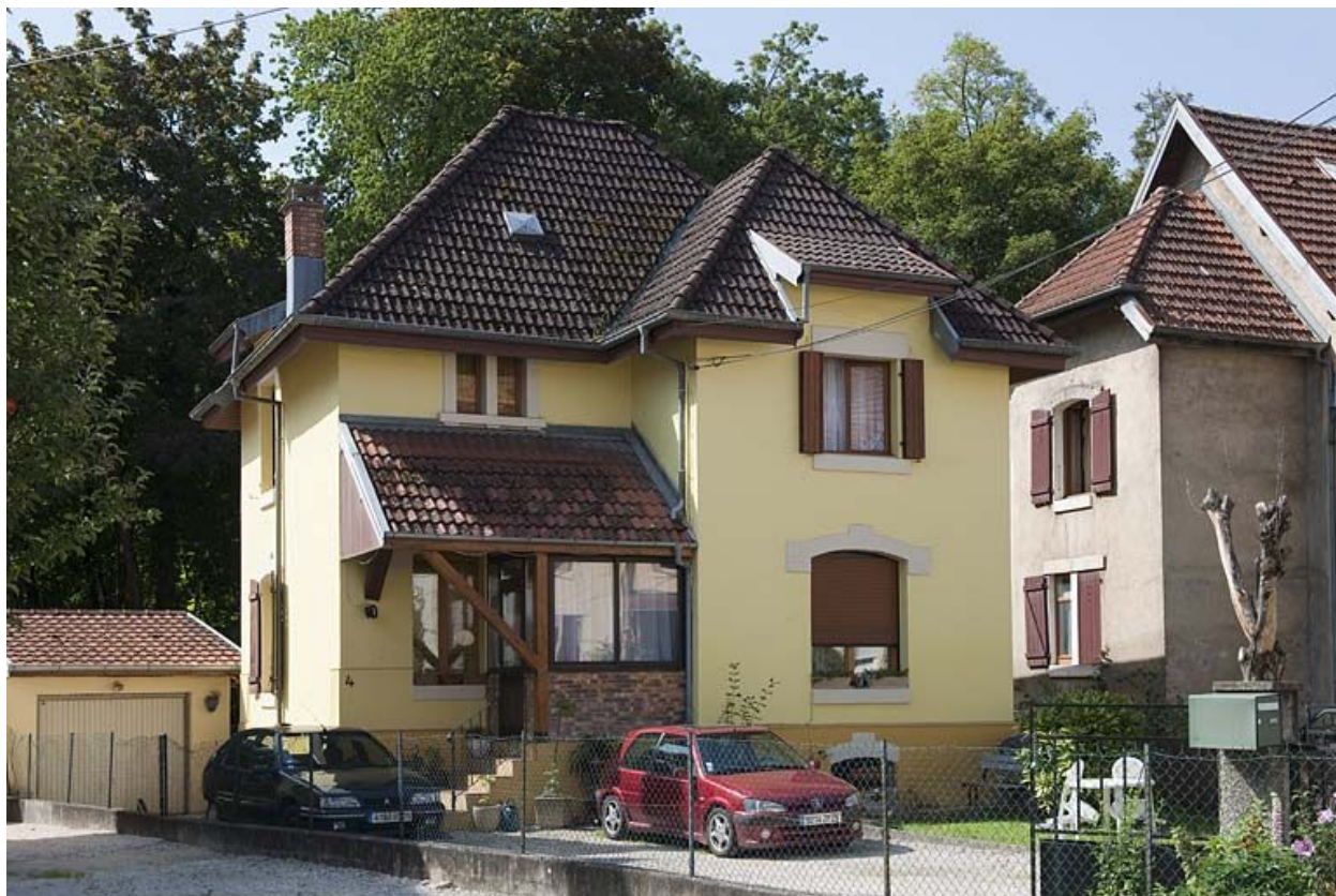
Maison individuelle rue de Flandres.
