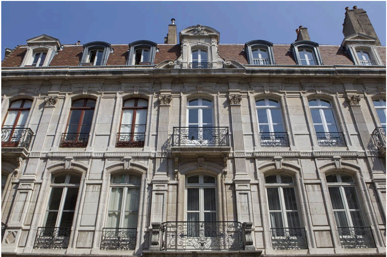
Détail de la travée centrale de la façade antérieure : partie supérieure.
