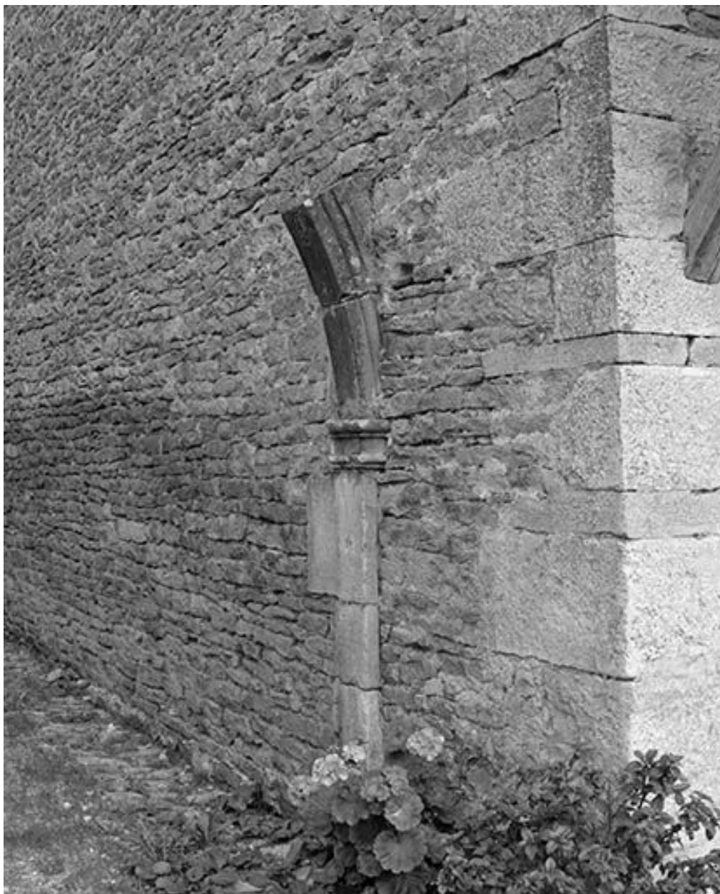
Face latérale gauche : départ d'un ancien arc.
