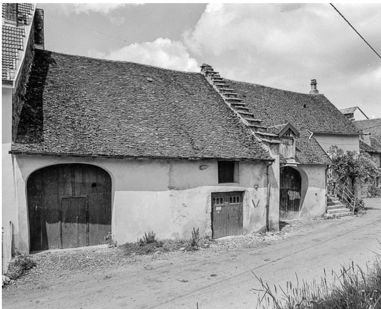
Ferme située rue Chateraine : façade antérieure.
