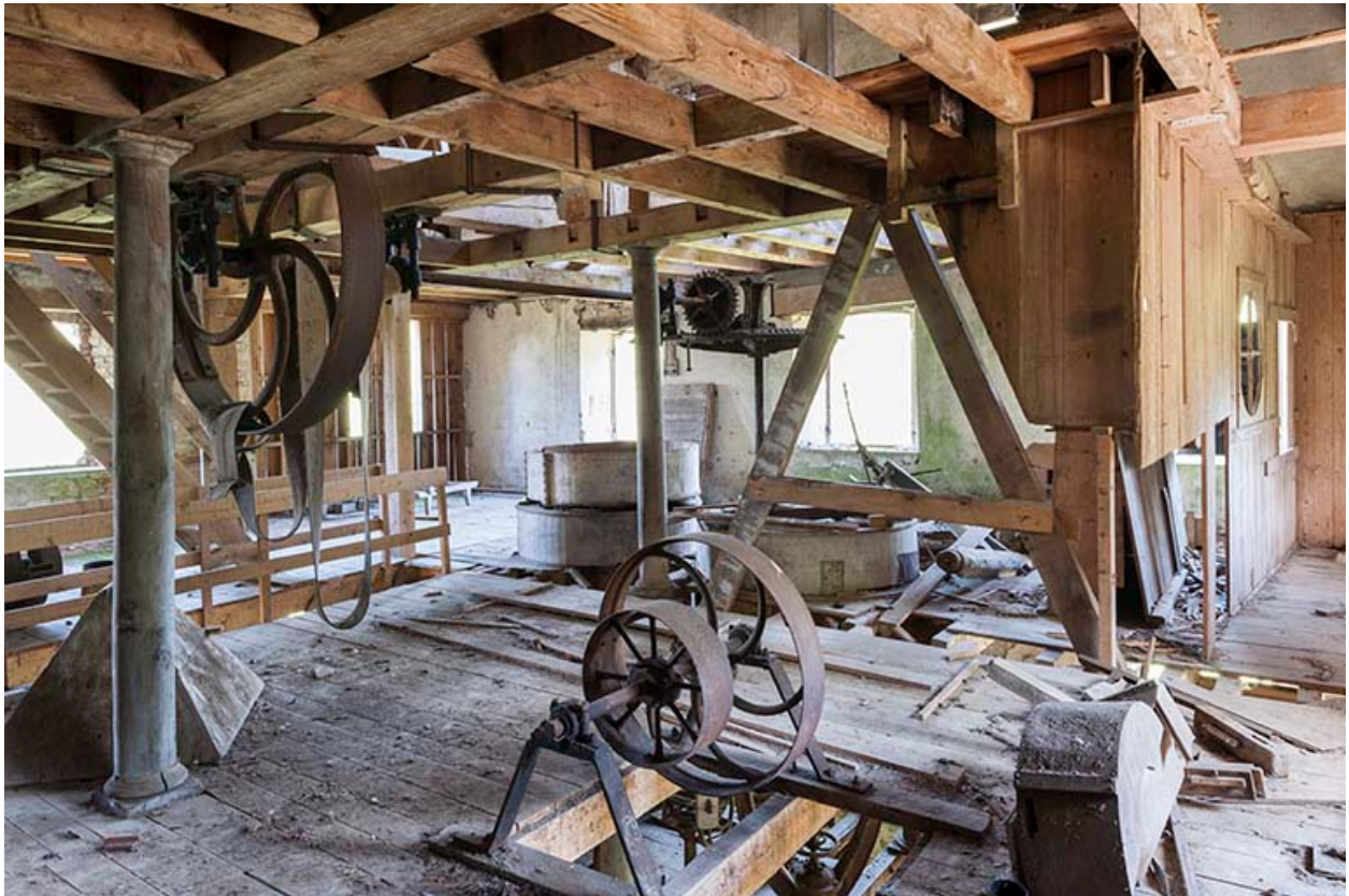
Premier étage. Vue d'ensemble depuis le sud-est.
