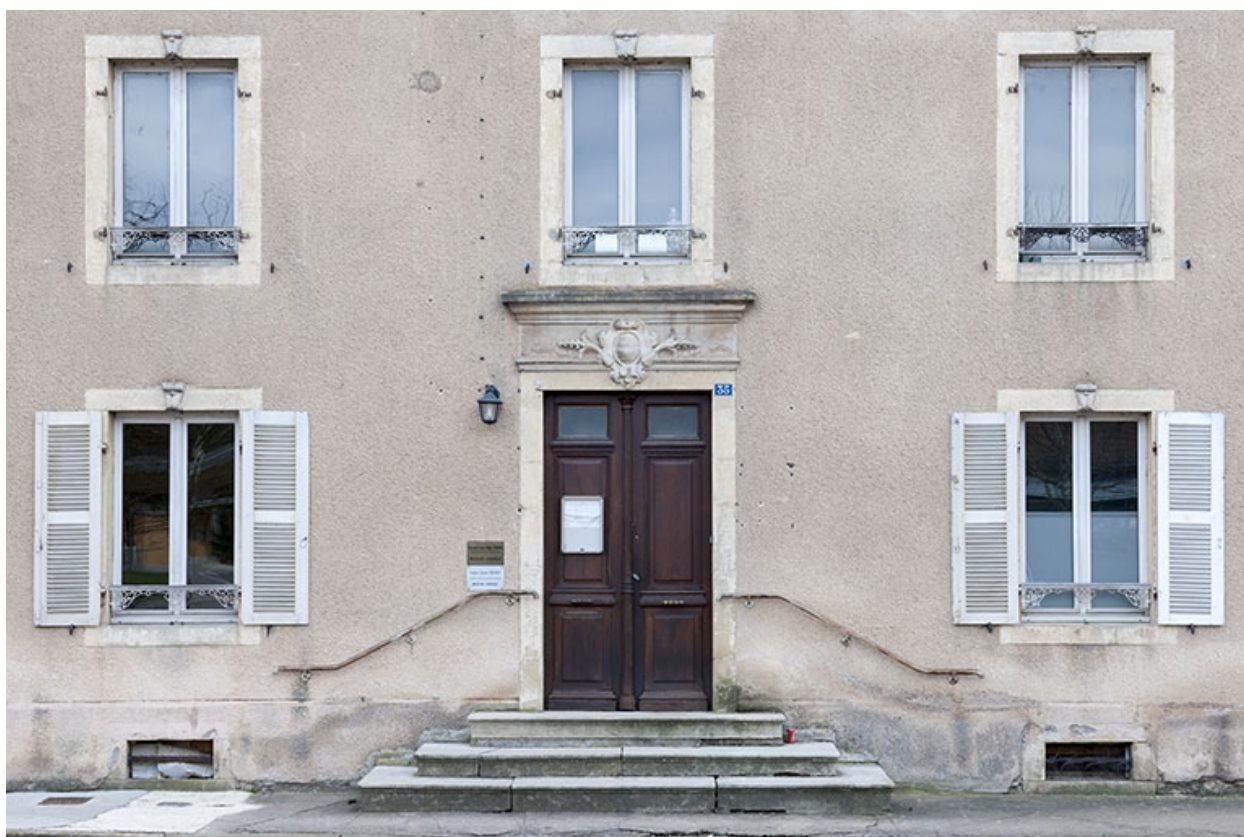
Façade antérieure : baies.
