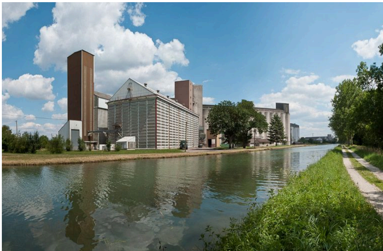
Vue des silos à Pacy-sur-Armançon.
