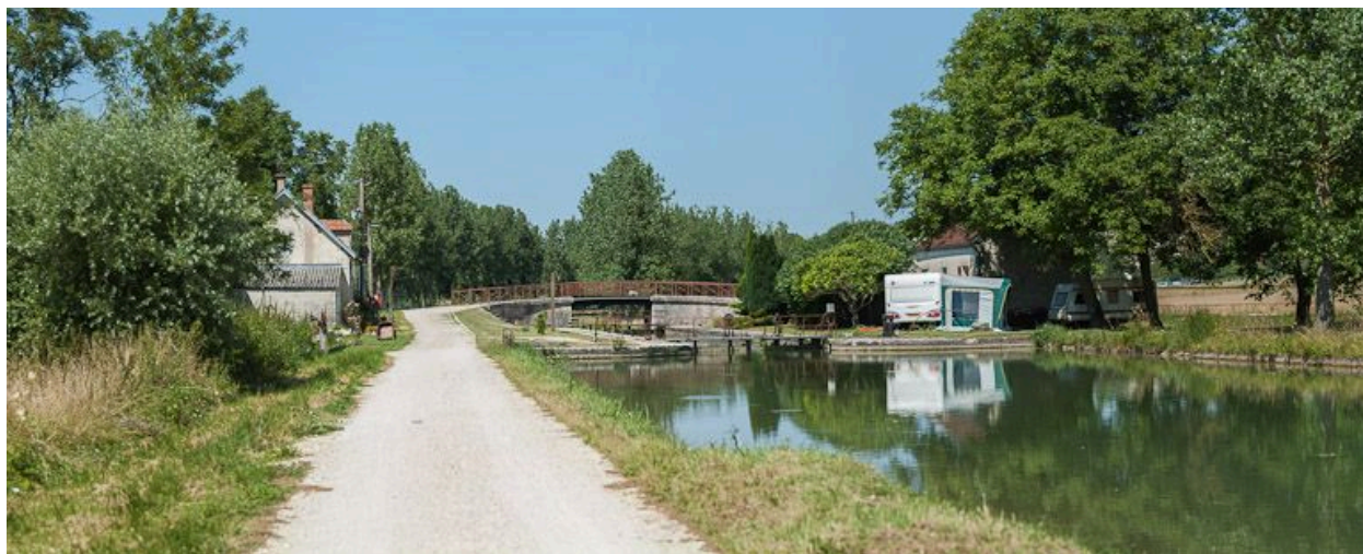
Site d'écluse vu d'amont.
