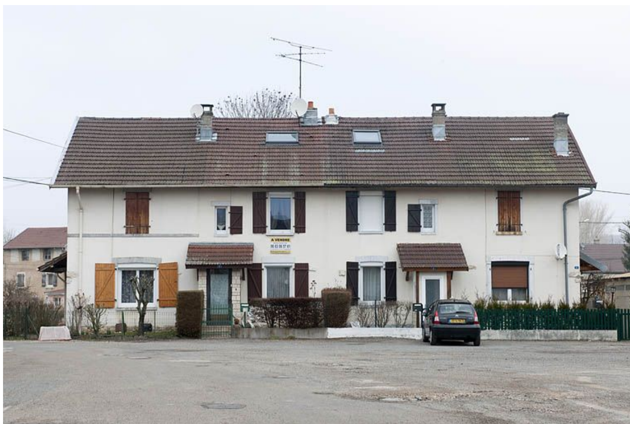
Immeuble à 4 logements. Façade sud.
