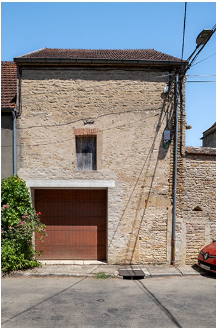
Façade d'une ancienne grange-étable sur rue.
