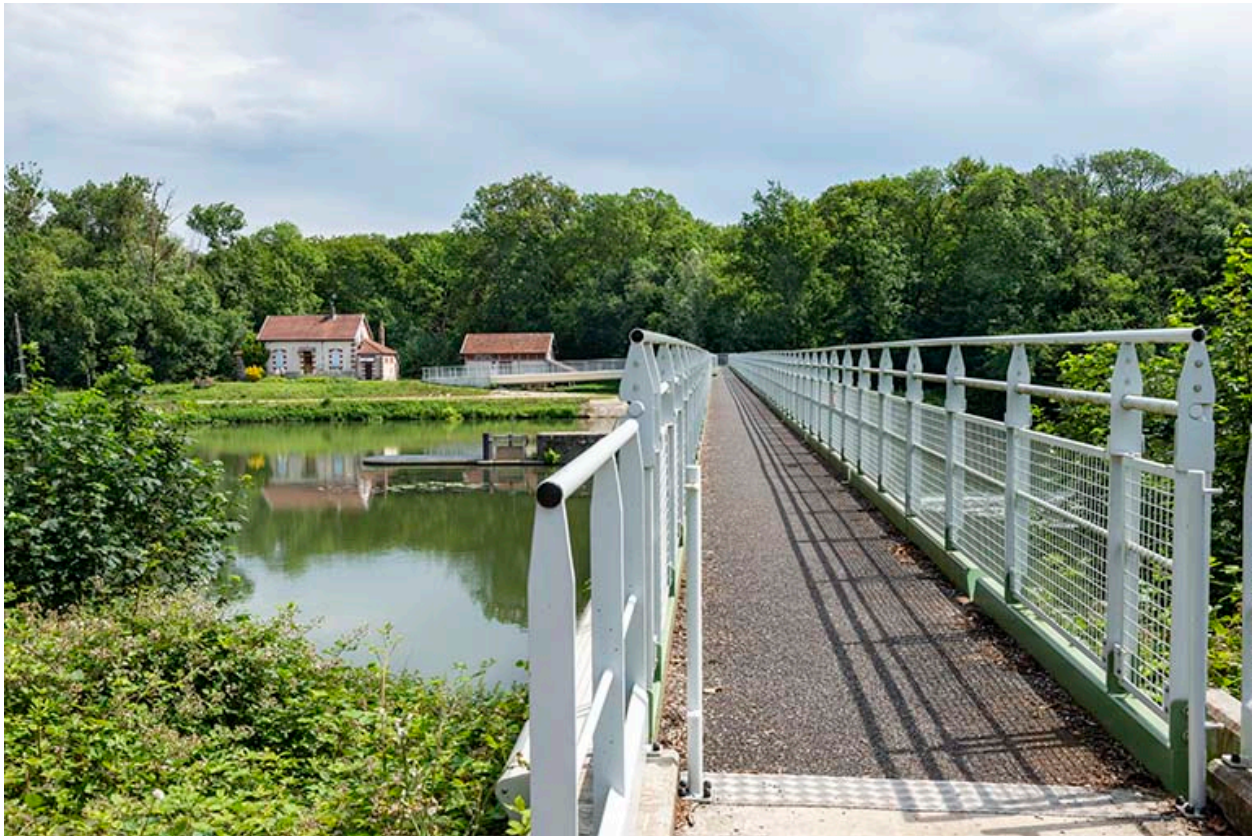
Barrage d'Apremont et la maison du barragiste sur la rive opposée.
