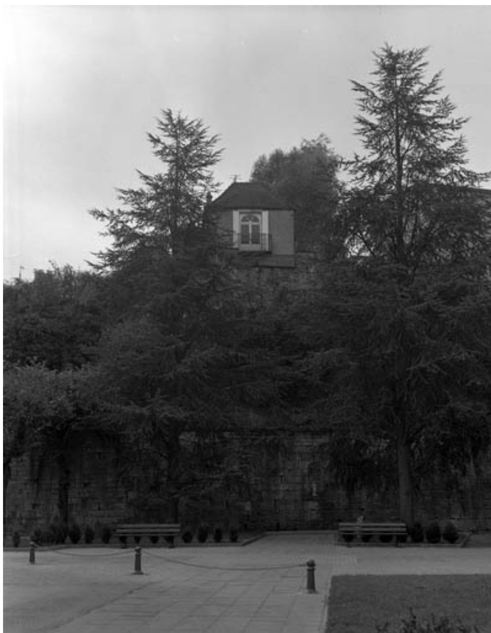
Restes du rempart du bastion du Boulevard dans la cour de l'hotel-dieu : de face.
