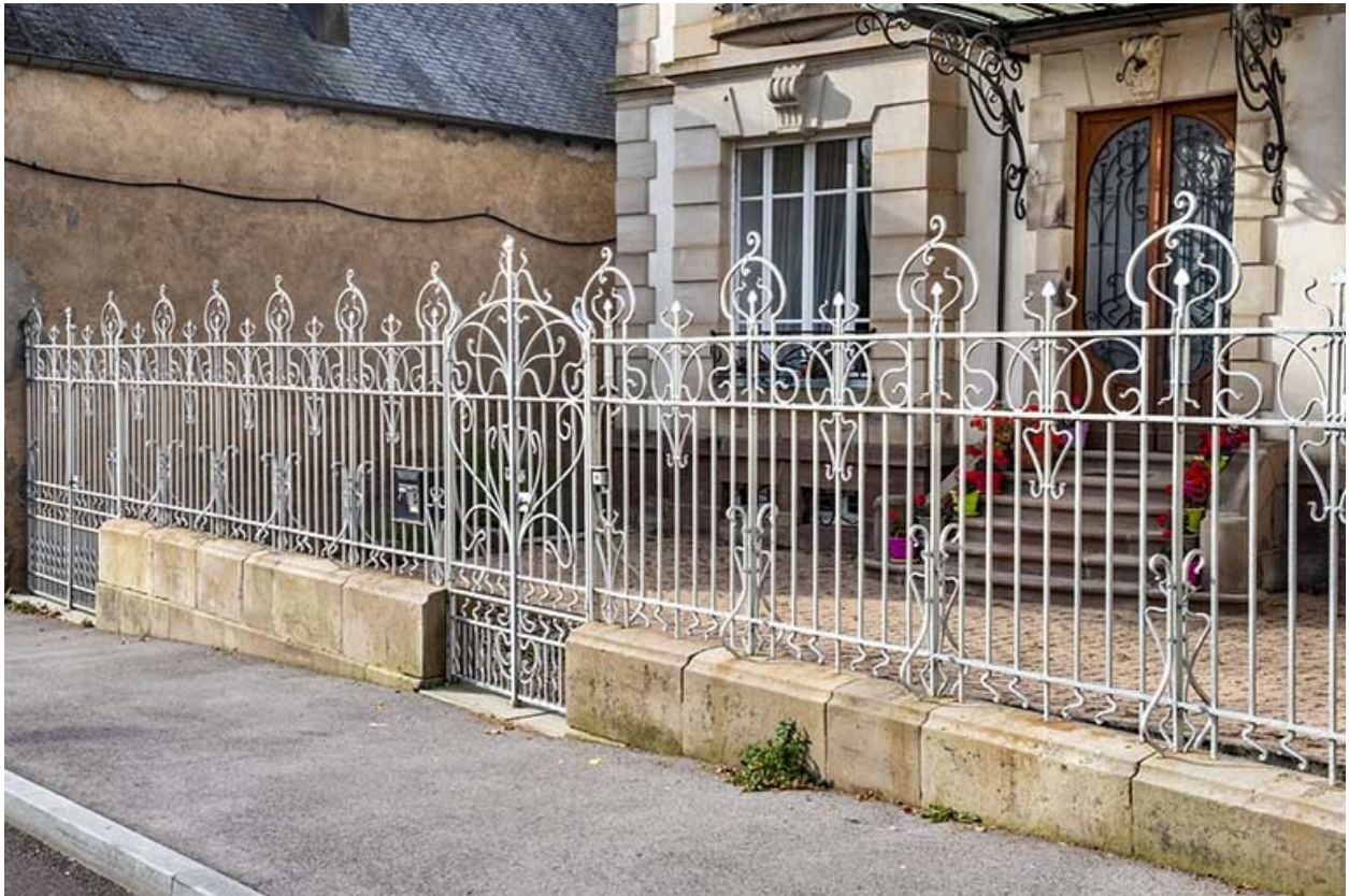
Grille de clôture.
