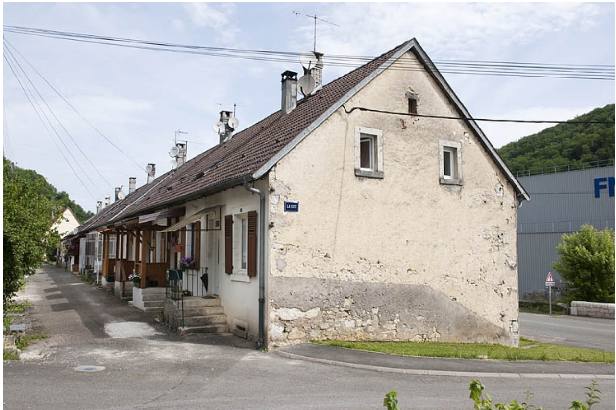
Logement d'ouvriers. Vue de trois quarts.
