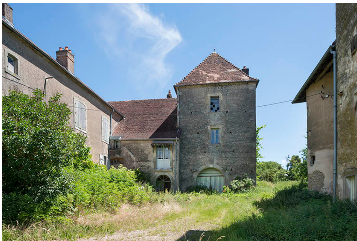
La cour intérieure de la maison forte.
