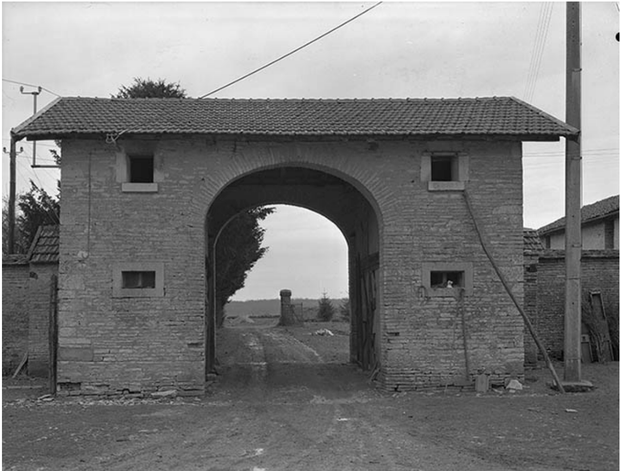
Ferme sise parcelle F1, du cadastre de 1958 : porche.
