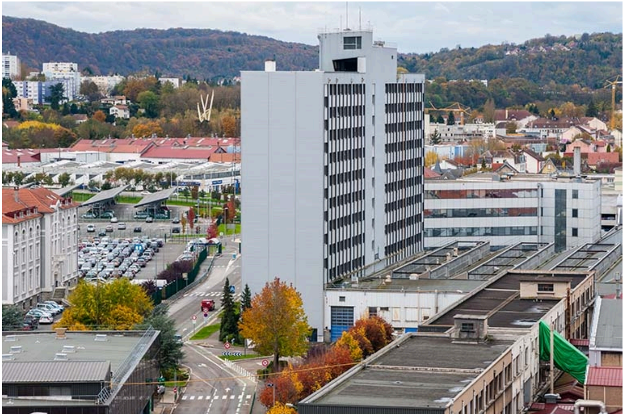
Partie ouest du site et Building Ouest.
