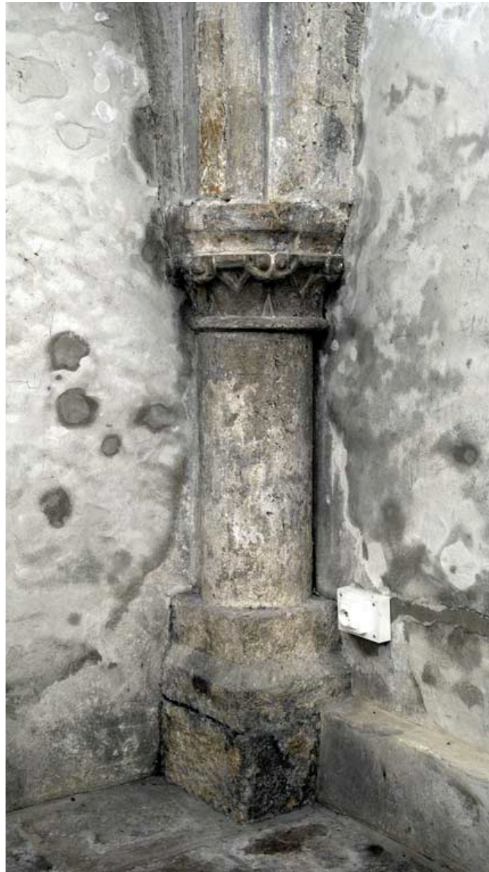
Chapelle dite des fondateurs : travée postérieure, colonne postérieure droite.
