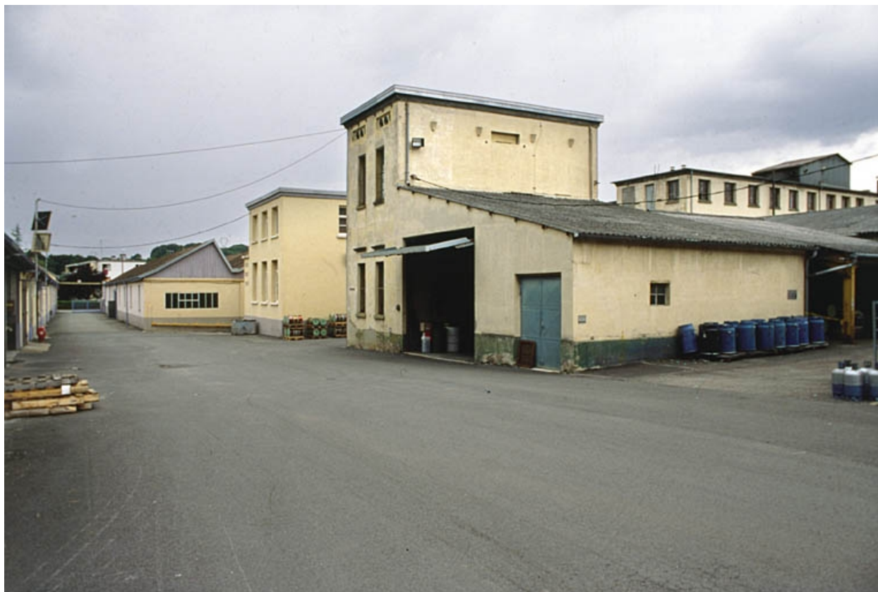
Atelier de fabrication, bureau d'études et transformateur.
