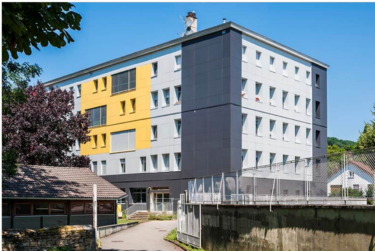
Façade latérale de l'internat après rénovation.
