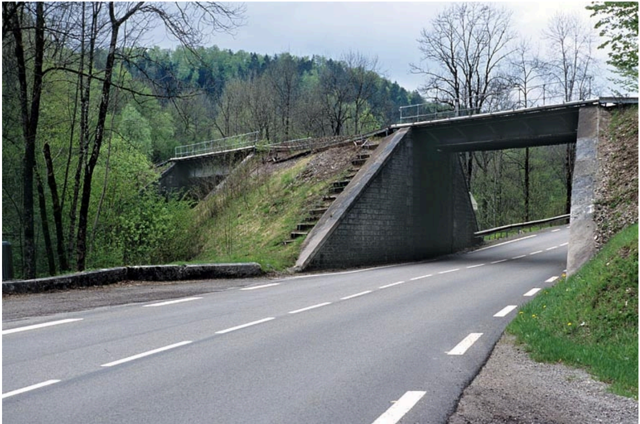
Pont sur la route nationale n° 5 : vue d'ensemble, depuis le côté Andelot-en-Montagne
