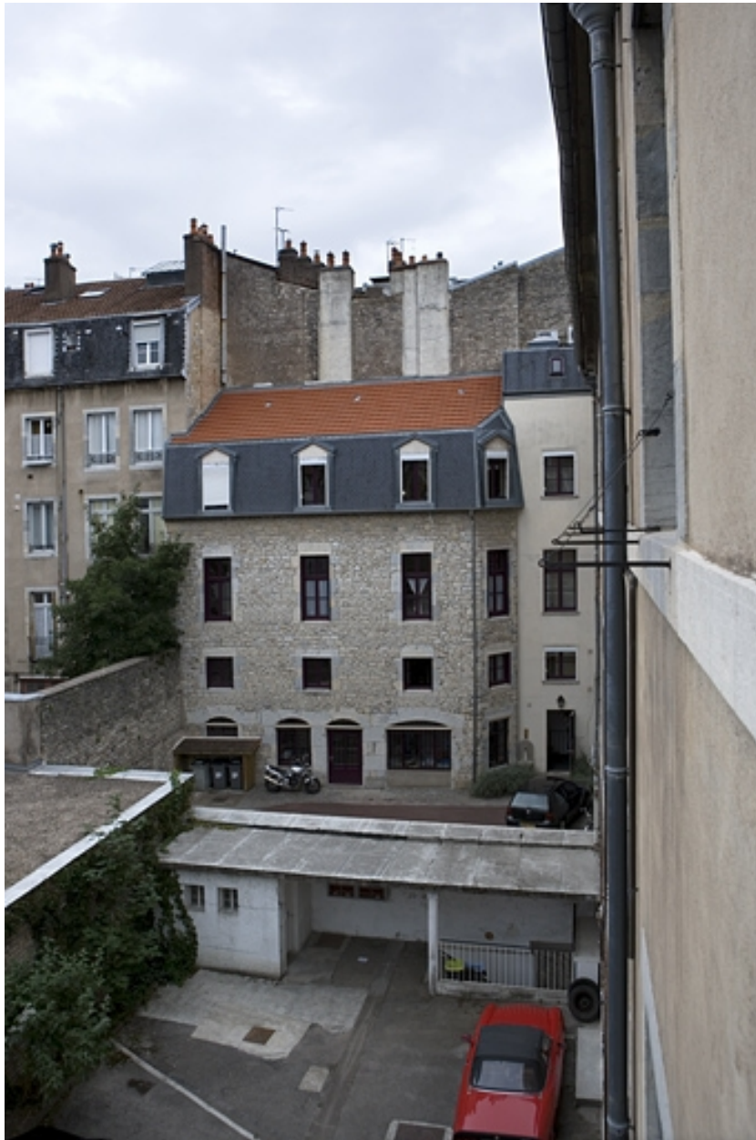
Vue d'ensemble de l'aile droite sur cour.
