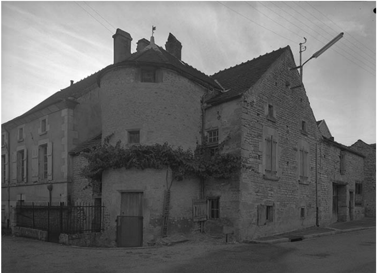
Tour ronde et maison. Façades sur rue.
