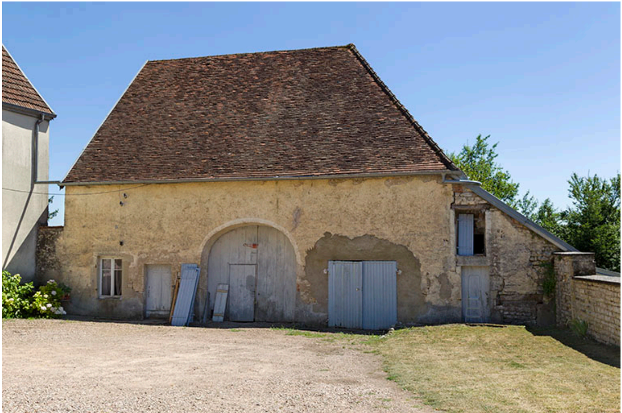
Vue générale du bâtiment agricole sur cour.
