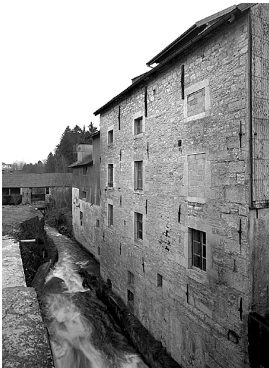
Façade sur le ruisseau de la Raillette.
