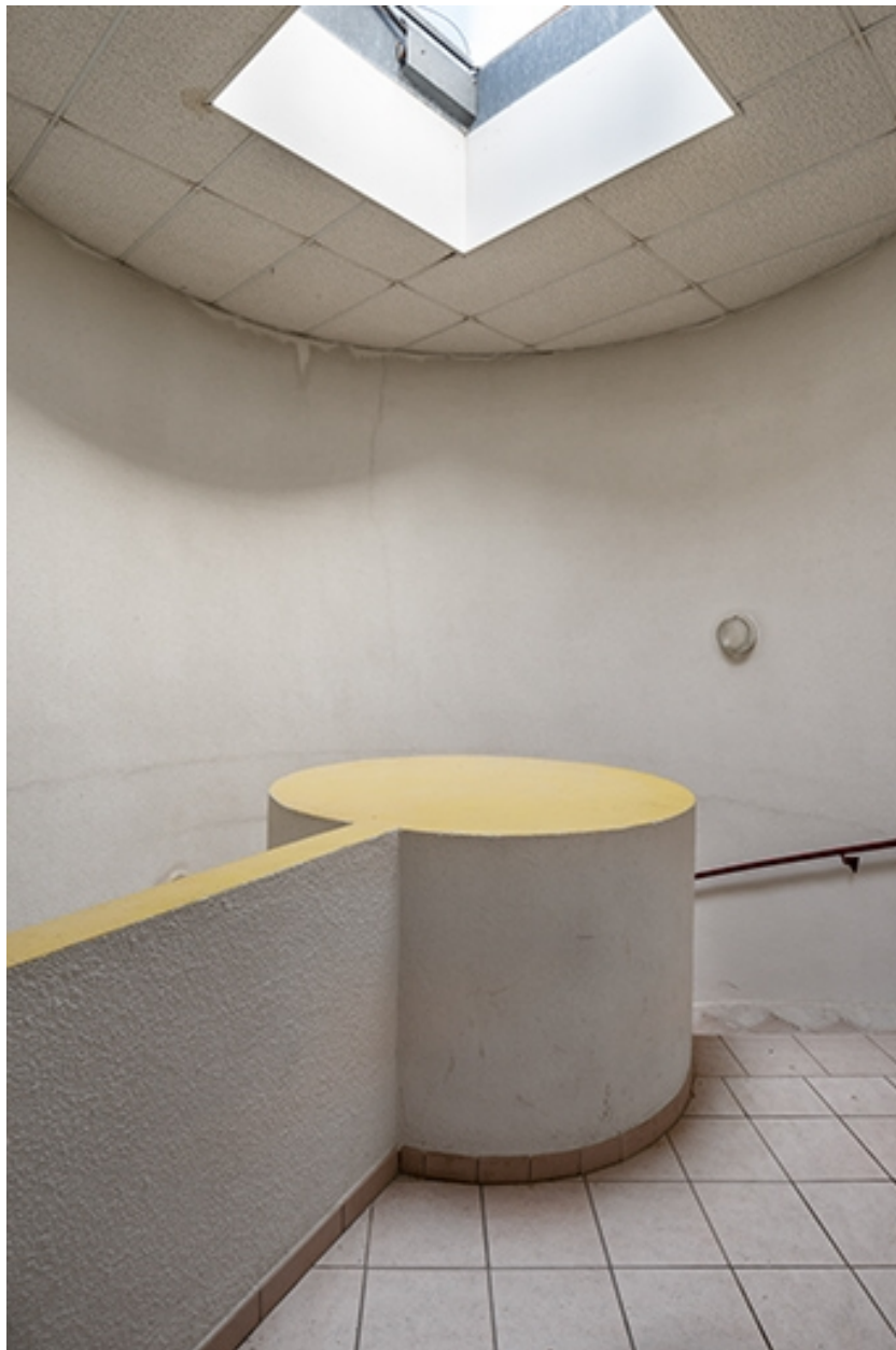
Escalier en vis créé dans l'ancienne tour du réservoir dans les années 1990, palier du second étage.
