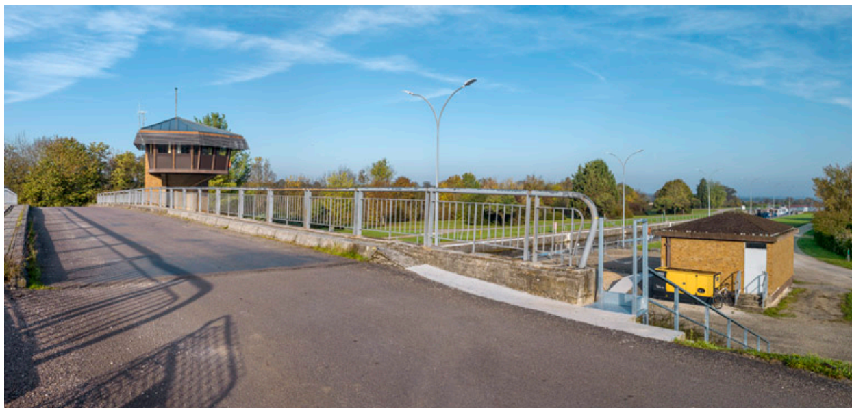
Vue d'ensemble depuis le pont sur écluse.
