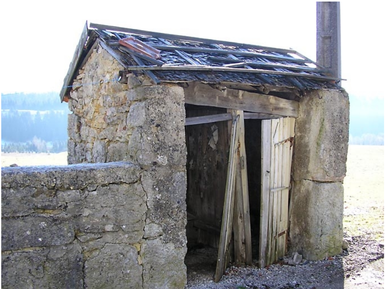
Les toilettes extérieures.
