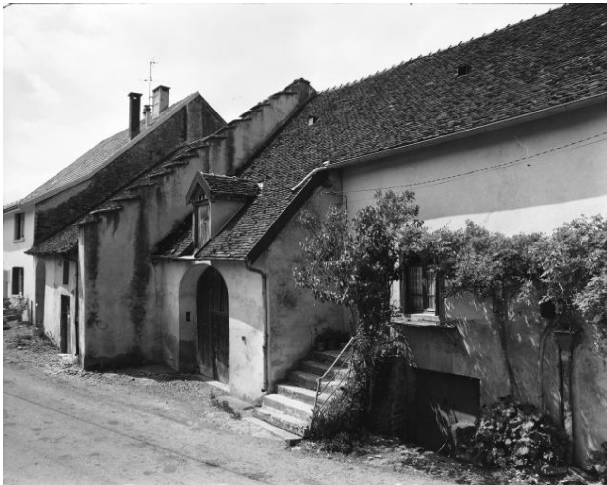
Ferme située rue Chateraine : façade antérieure.
