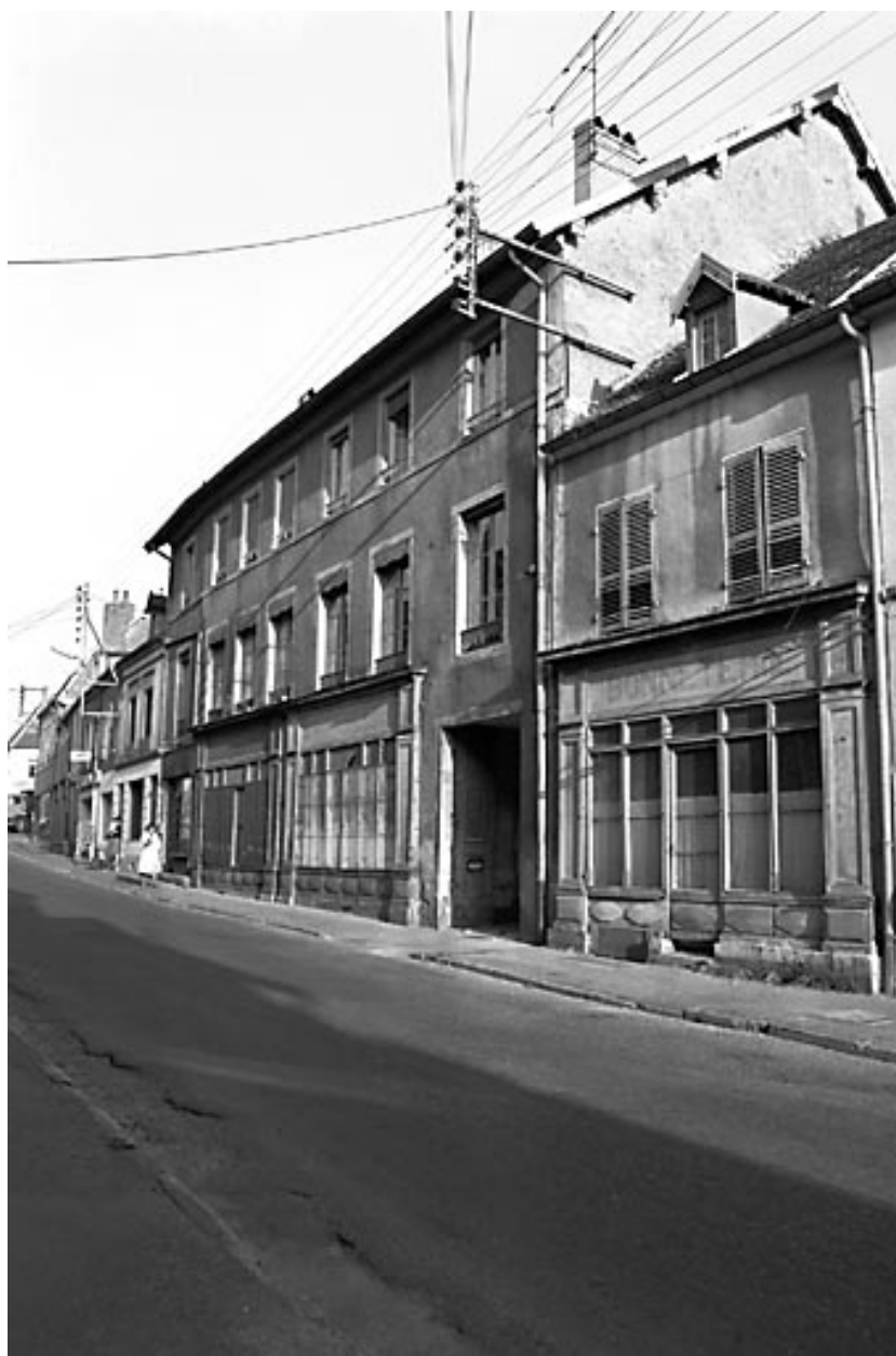
Façade antérieure avec magasins au rez-de-chaussée.
