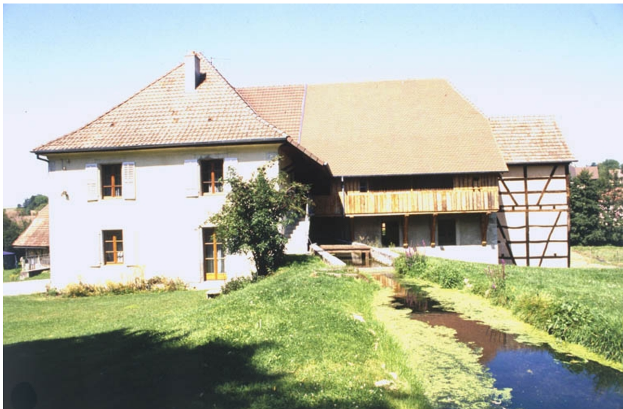
Vue d'ensemble depuis le sud-est. Au premier plan : le canal d'amenée.
