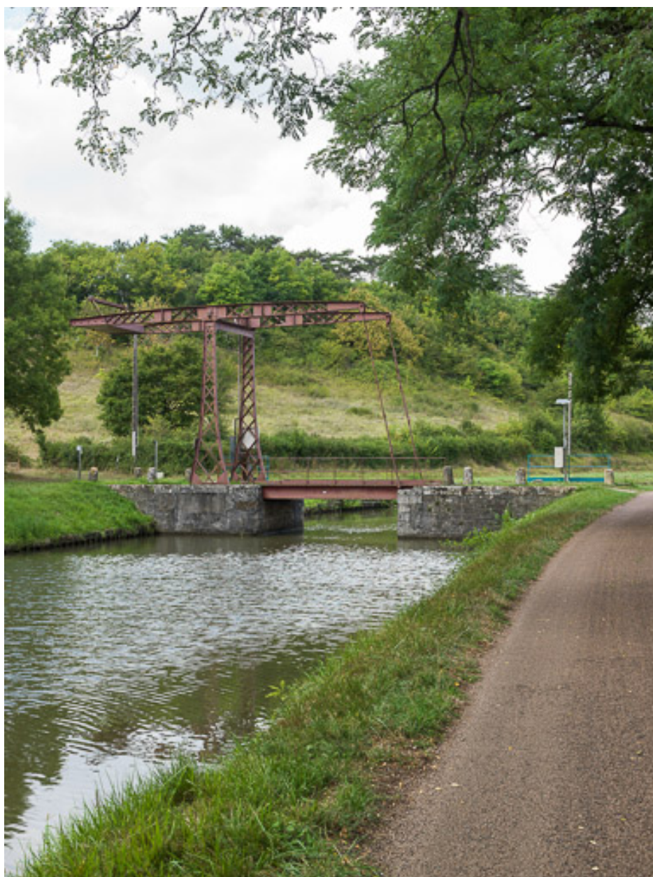
Vue d'ensemble du pont.
