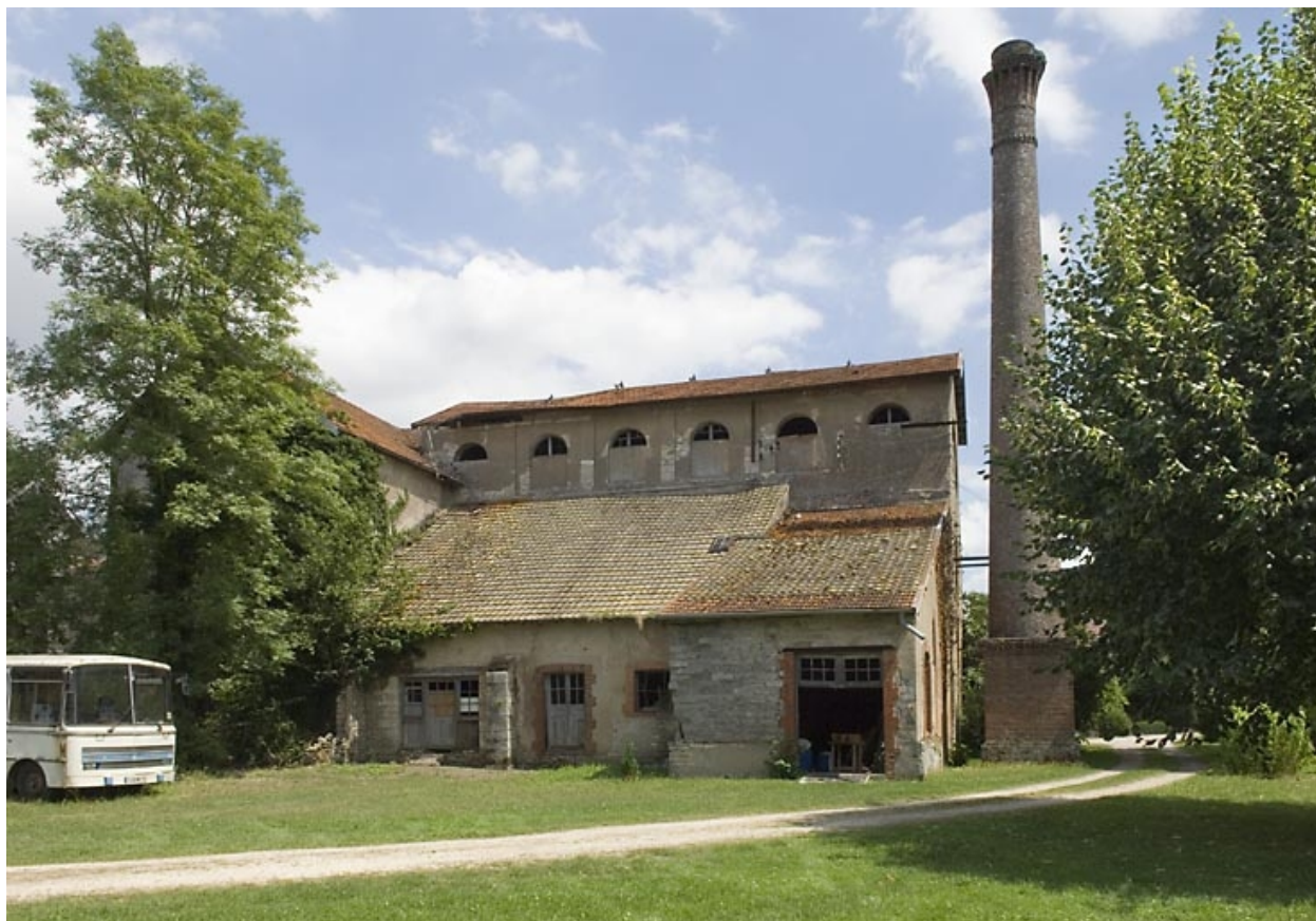
Elévation ouest du haut fourneau.
