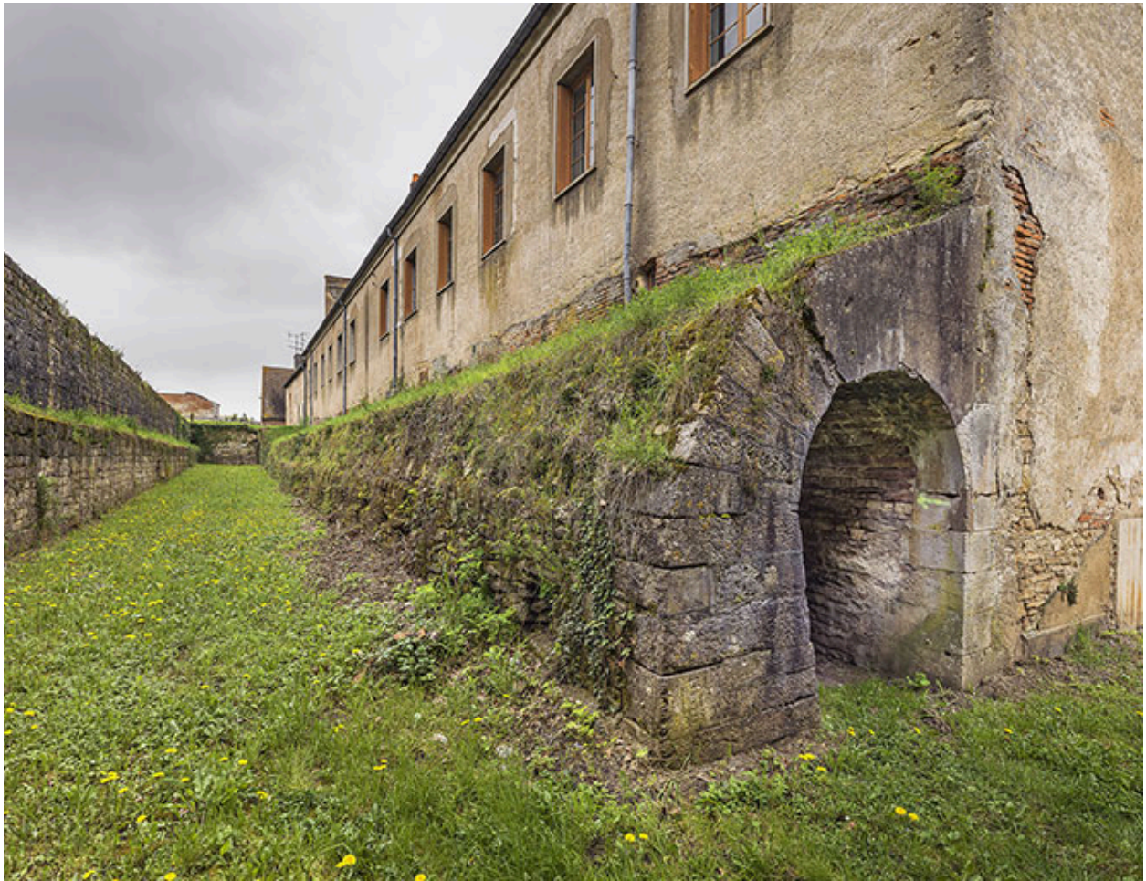
La galerie voûtée reliant la tour basse des Moulins au bastion de la tour Beauregard.
