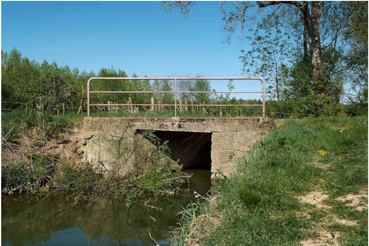
Vue d'ensemble du pont du Moulin Neuf à Romenay.
