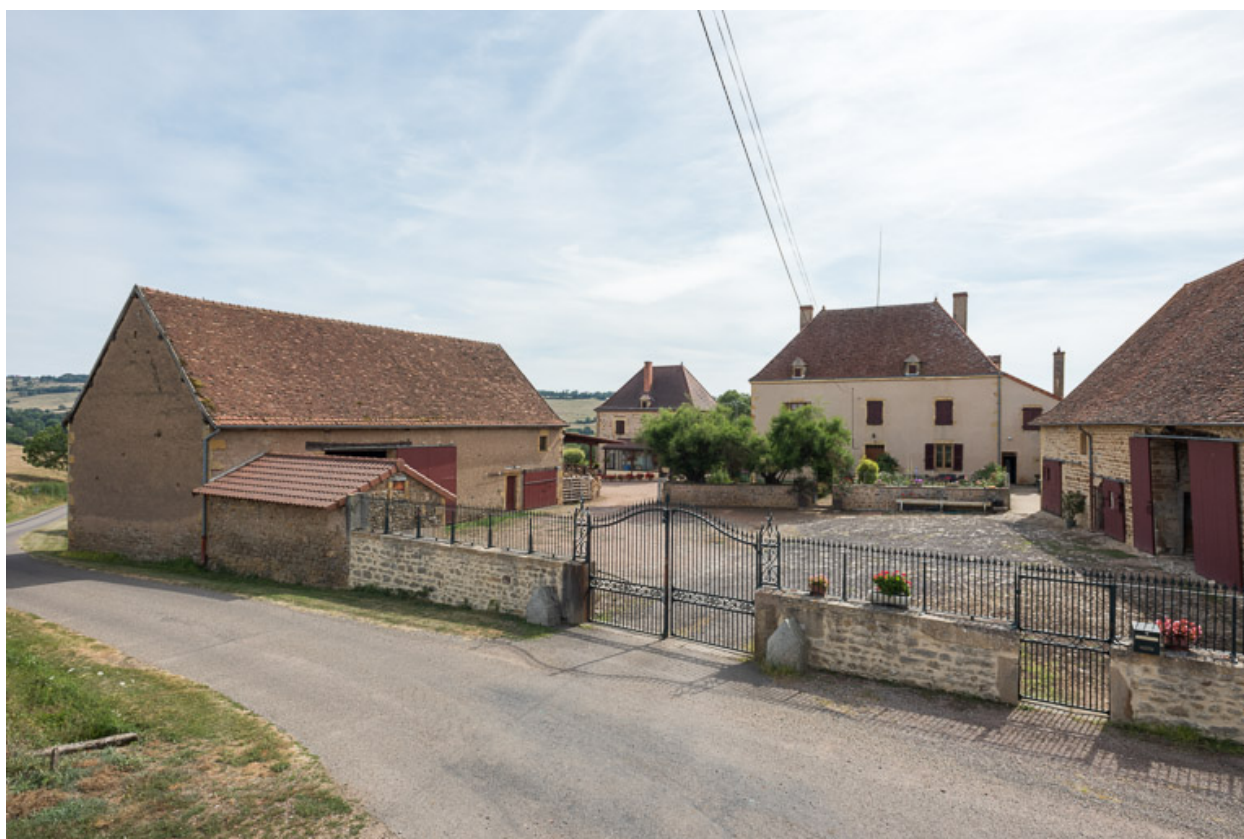
Vue générale des bâtiments du domaine du Haut de Rouy
