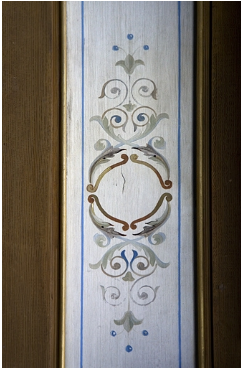
Intérieur, pièce du premier étage : détail du décor d'un encadrement de fenêtre.
