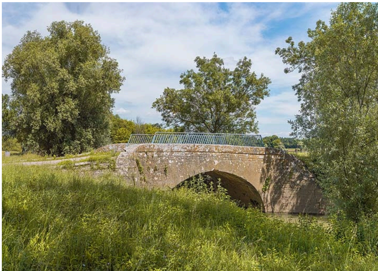
Vue d'ensemble du pont.
