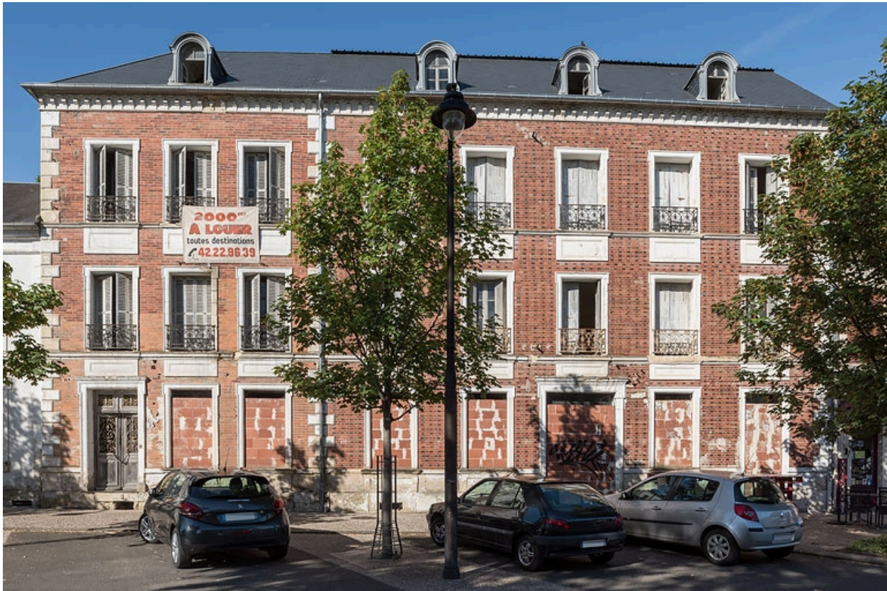
Façade de l'extension de Jules Guimard.
