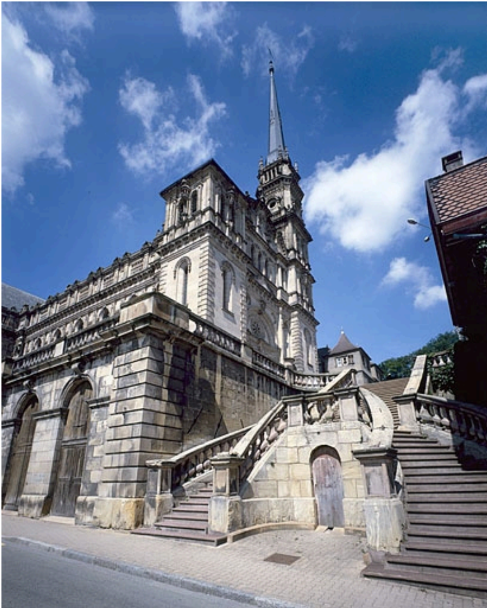
Escalier de la terrasse et façade principale.
