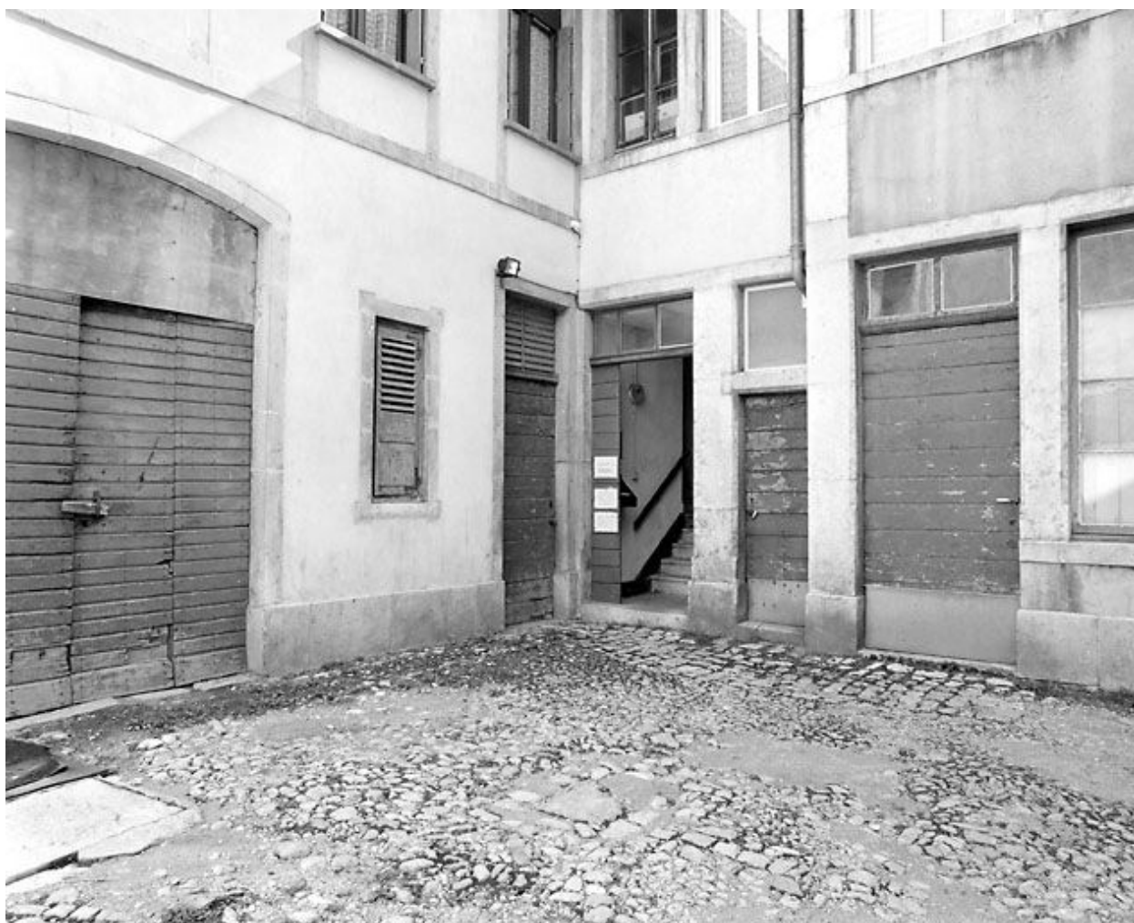
Angle de la remise et de l'atelier.
