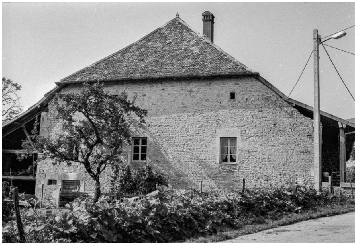
Ferme cadastrée 1961 AC 31 : façade latérale gauche.
