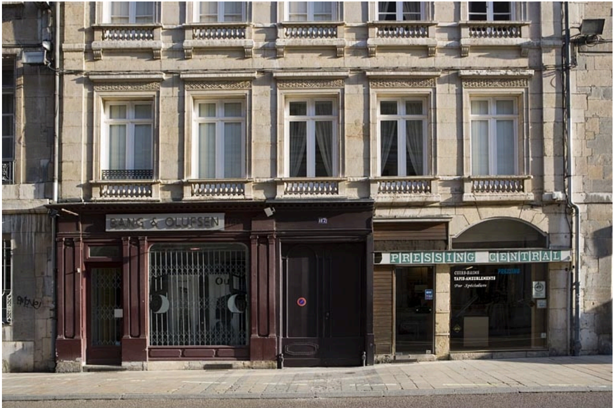
Logis principal, façade sur rue : détail du rez-de-chaussée.
