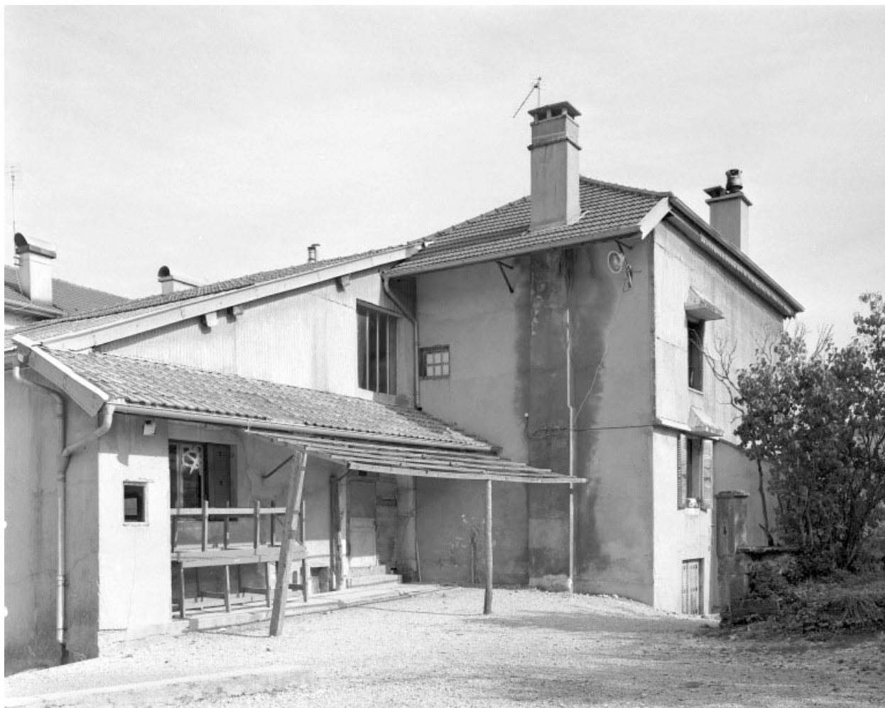
Côté droit du bâtiment.
