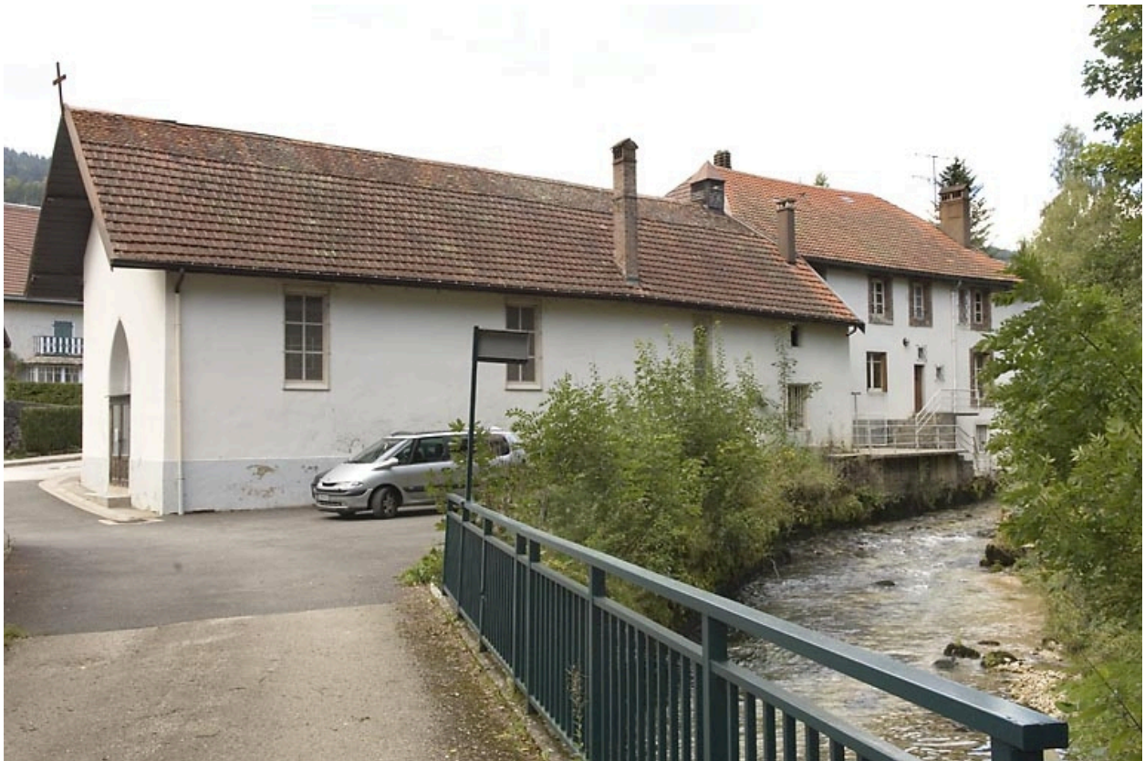
Chapelle rue des Forges : façade latérale droite.
